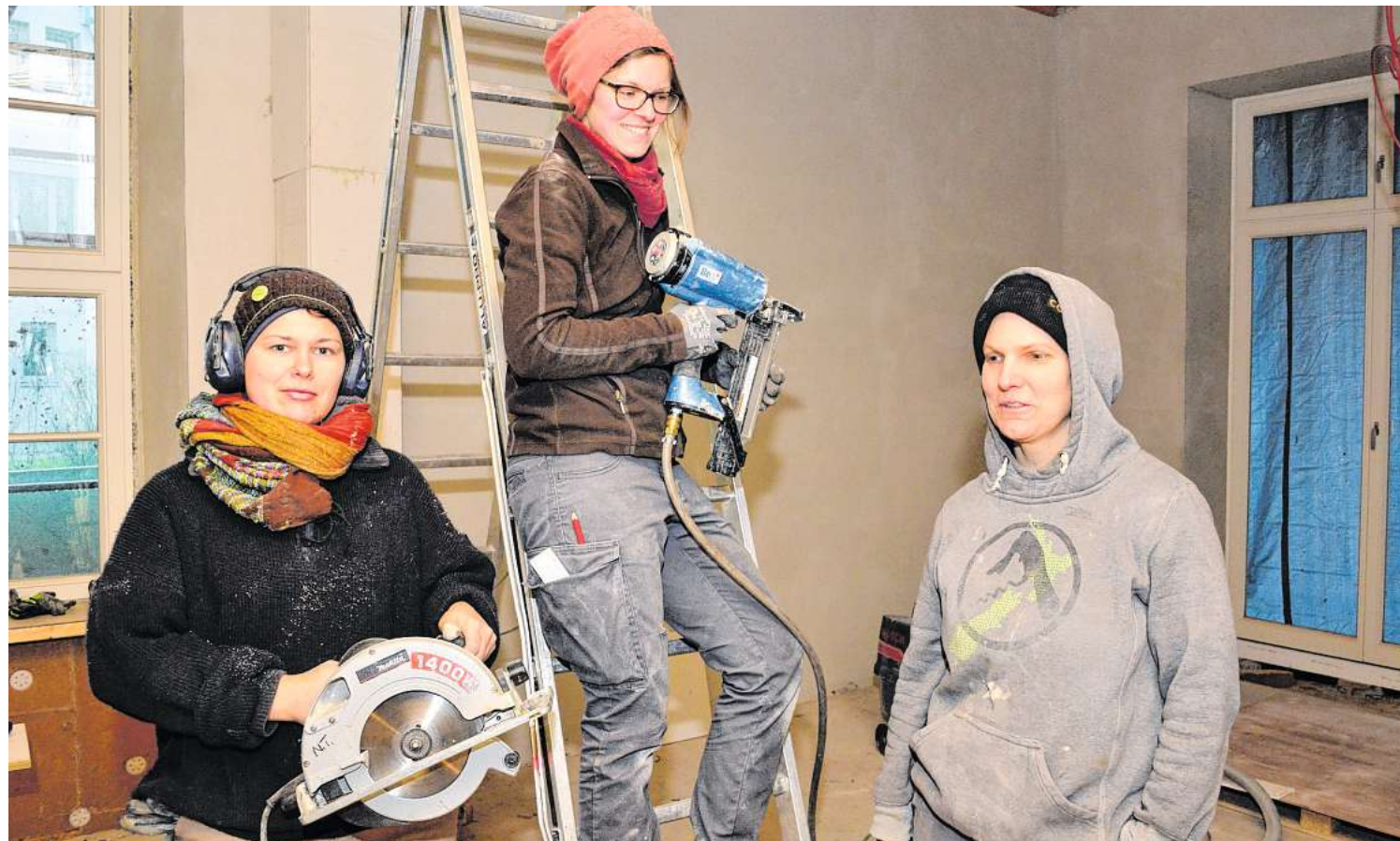
Jana Neuhaus, Saskia Schniete und Nadja Tegtmeyer (v.l.) verkleideten gestern eine Decke im Esszimmer. Alle drei Frauen arbeiten seit Langem an dem Projekt mit, wollen demnächst auch in den Wohnbereich des Hauses einziehen. FOTOS: PETER BINDER
